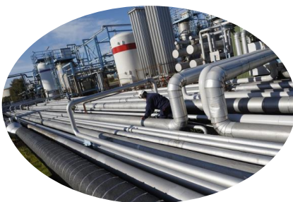
パイプコーティング
